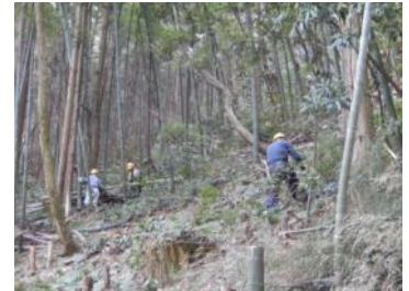
▲体力的に厳しい急斜面での作業
