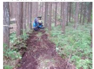
▲作業道造り作業中
