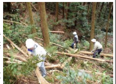
▲間伐と遊歩道づくりによる土留め
